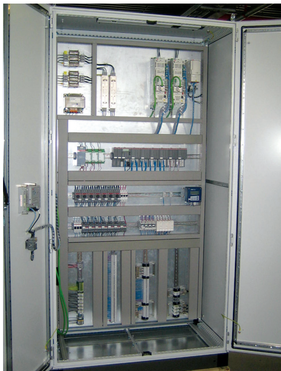
Bild 1. Eine SPS und zwei Servo-Regler von ABB übernehmen die Steuerungs- und Antriebsaufgaben in dem Anlass- und Drehzahlsteller
