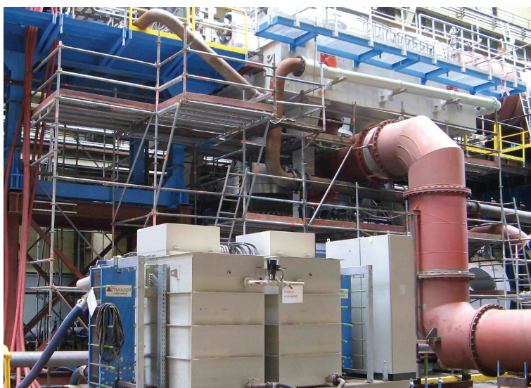
Bild 4. Der auf einem Grundrahmen aufgebaute Anlass- und Drehzahlsteller versorgt den Windkanalprüfstand mithilfe der beiden Elektrolyttanks mit den eingebauten Elektrodensystemen und den beiden Plattenwärmetauschern mit einer Kühlleistung von jeweils 3,5 MW
